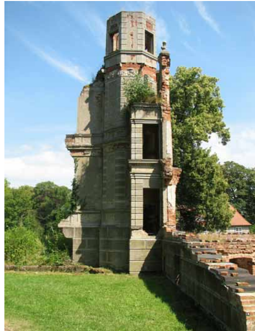
Treppenturm der Schlossruine
