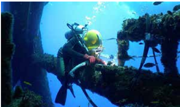
Abb. 1: Unterwasser-Schweißfachkraft bei Reparaturarbeiten
