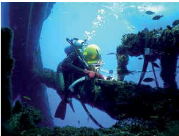
Abb. 2: Unterwasser-Schweisser bei Reparaturarbeiten
