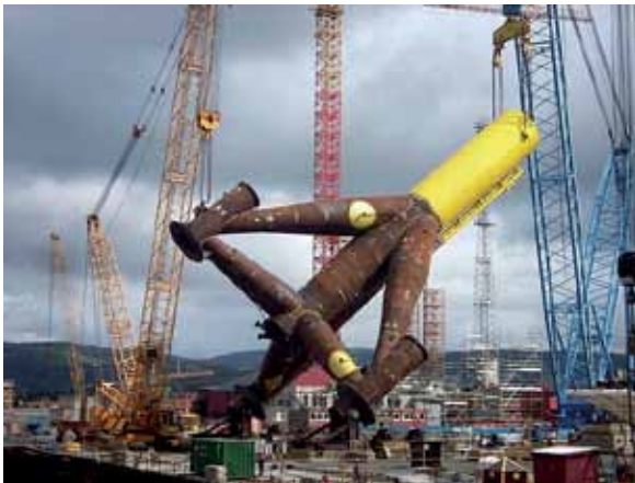
Abb. 1: Errichtung von Offshore-Windanlage
