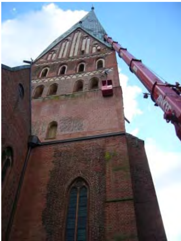
Schwindelfreiheit ist Voraussetzung für die photogrammetrischen Aufnahmen am Turm der St. Johannis-Kirche
