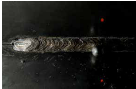
Kehlnaht mit Riss, linksseitig beleuchtet. Der Riss im Endkrater ist gut erkennbar.
