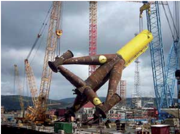
Abb. 1: Errichtung von Offshore-Windanlage
