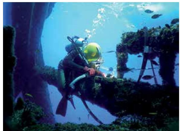
Abb. 2: Unterwasser-Schweißer bei Reparaturarbeiten
