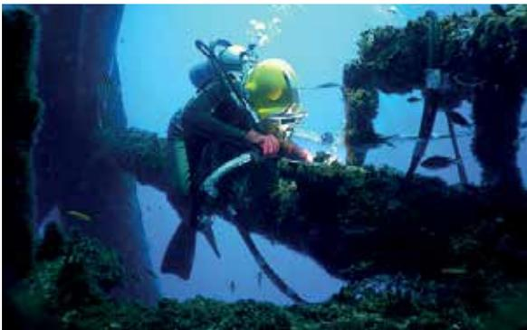
Abb. 1: Unterwasser-Schweißer bei Reparaturarbeiten
