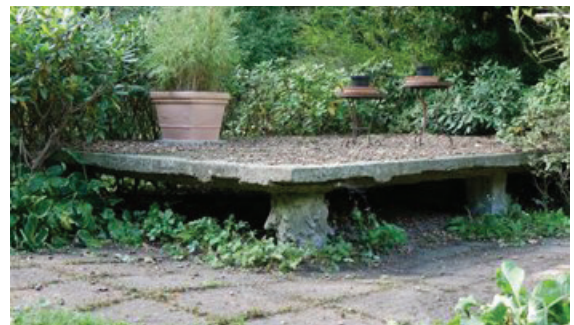
Abb. 1: offenes Fundament einer ehemaligen Gartenhütte
